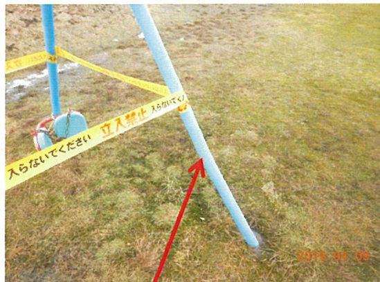
雪に押されて破損した 幼児用フランク
